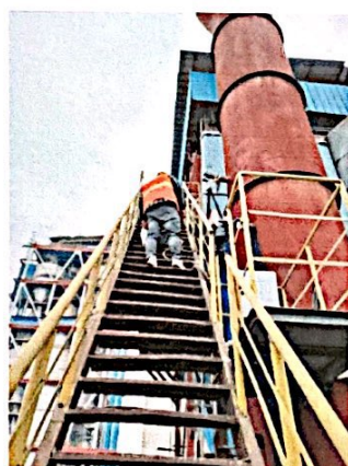
二线煤磨排气筒
