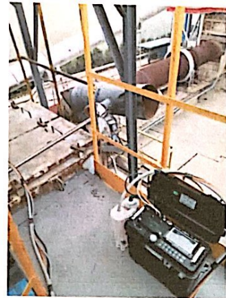
煤磨二号排气筒
